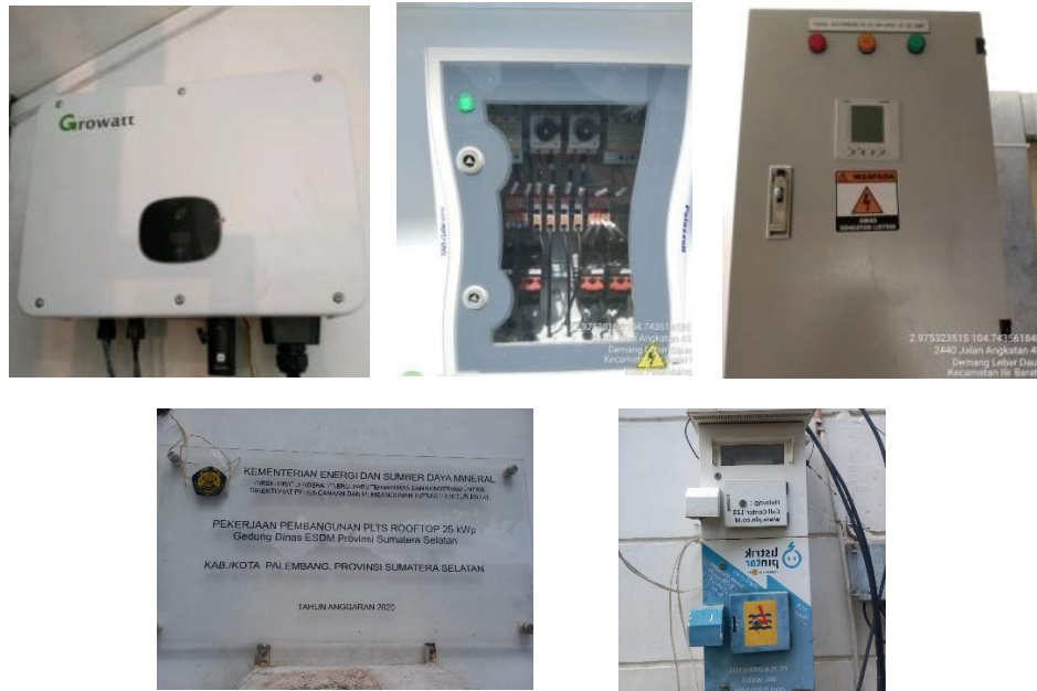
Gambar 3.8b Dokumentasi Komponen PLTS Atap
