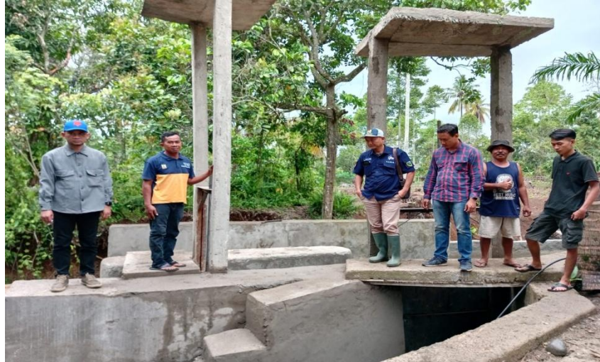
Gambar 5.4. Monitoring dan pengawasan Konstruksi Irigasi Air Satran
