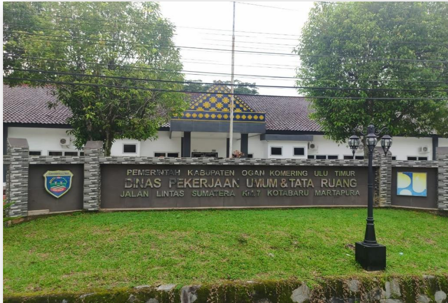
Gambar 2.1 Kantor Dinas PUTR Kab. OKU Timur
