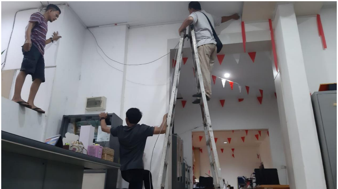
Gambar 3. 10 Perakitan/Instalasi Komponen Server
