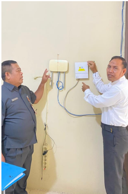
Gambar 3. 18 Foto Kegiatan pemasangan jaringan internet
