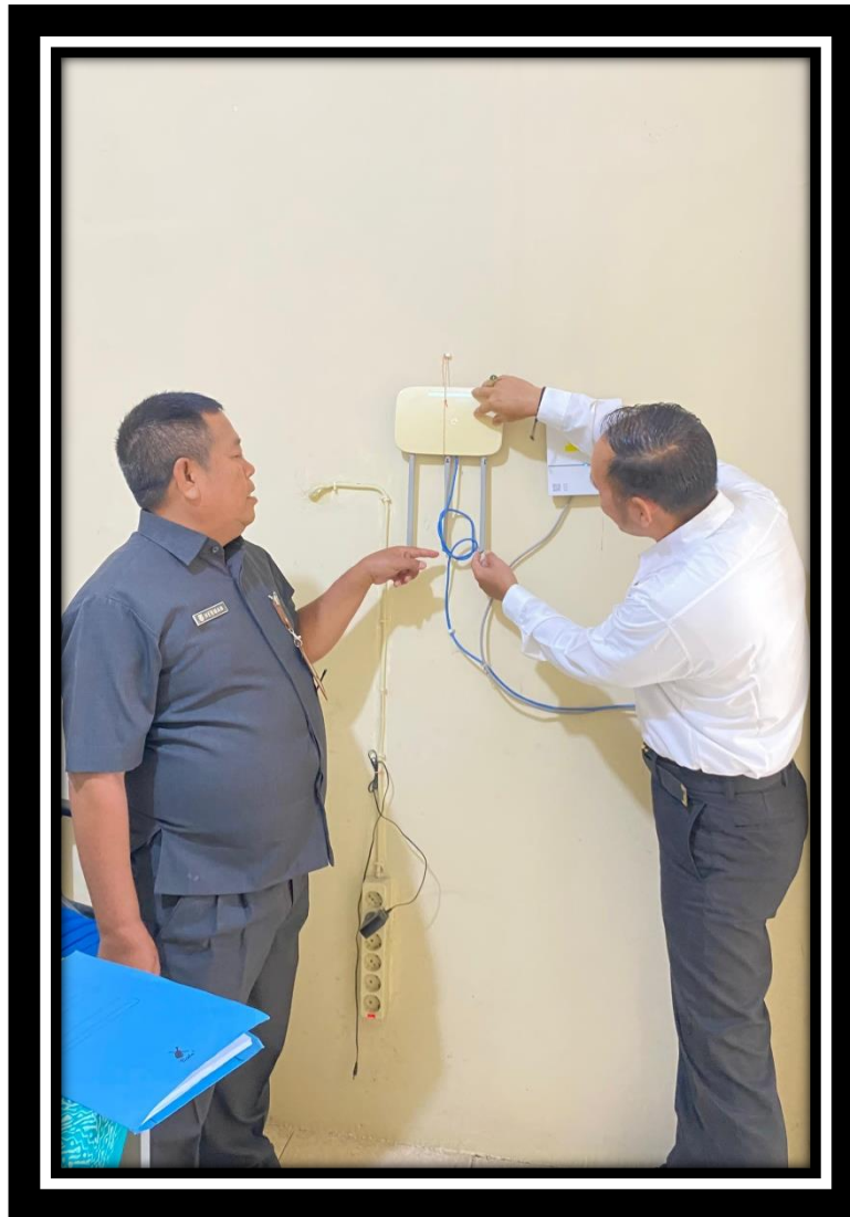
Gambar 3. 13 Pemasangan Instalasi Jaringan Internet kantor camat babat supat
