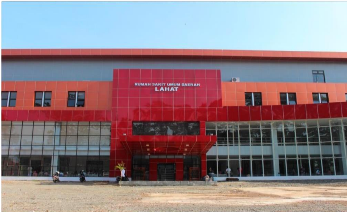
Gambar 2.1 Gedung RSUD LAHAT
