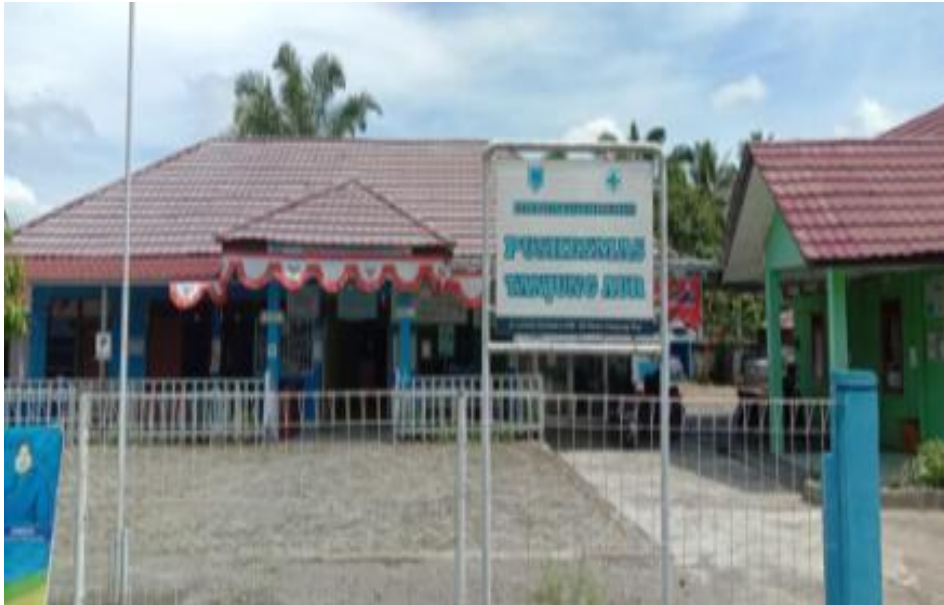
Gambar 1.1 Gedung Puskesmas Tanjung Aur
