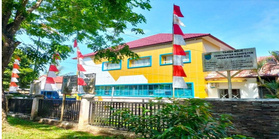
Gambar 2.1 Kantor Inspektorat Kab. Ogan Komering Ilir
