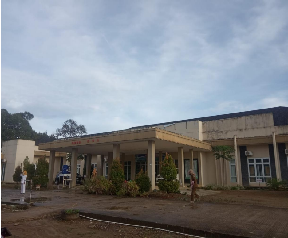
Gambar 2.1 Gedung utama RSUD Semende Darat Laut
