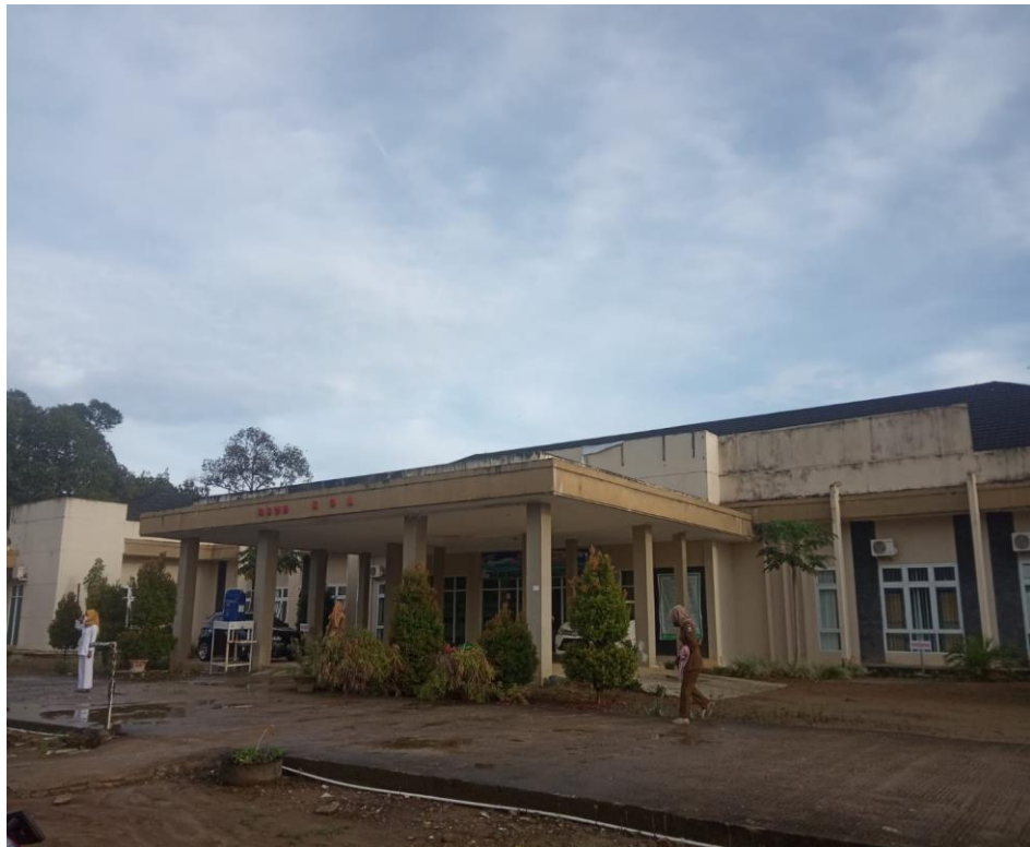
Gambar 1.1 gedung utama RSUD Semende Darat Laut
