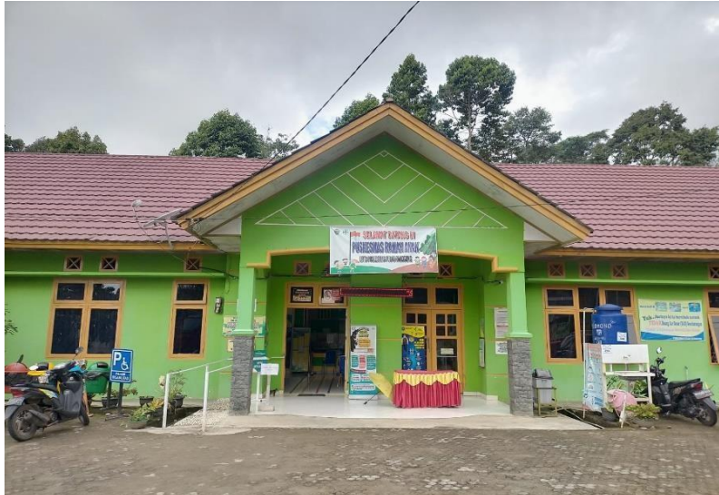
Gambar 2.1 Gedung UPT Puskesmas Pulau Panggung
