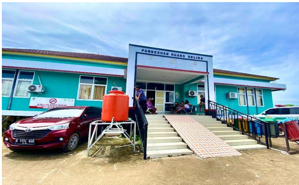
Gambar 2.1 gedung utama UPTD Puskesmas Muara Belida
